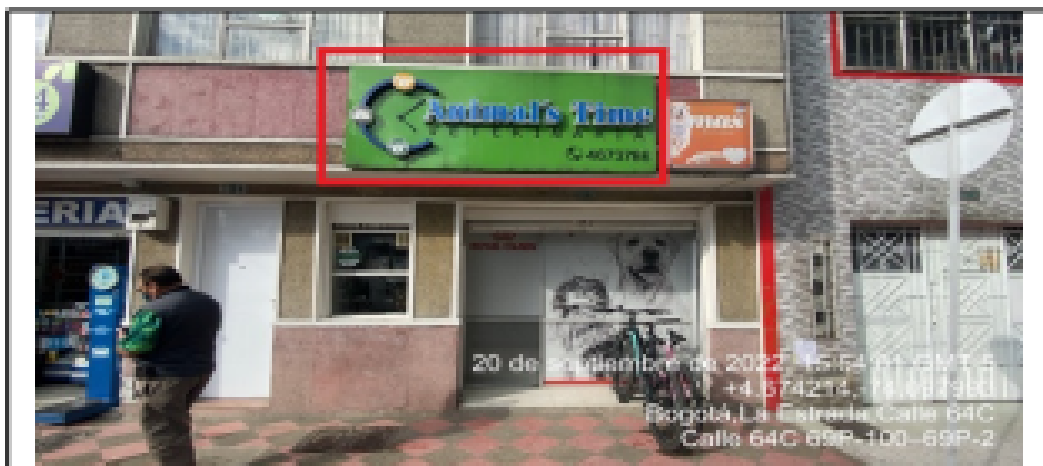
En la cual se evidencia un elemento tipo aviso en fachada perteneciente a la sociedad ANIMAL'S TIME SAS , el cual se encuentra ubicado en antepecho de segundo piso, al momento de la visita se encontraba instalado sin el registro ante la SDA.
